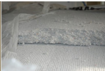
Panneaux semi-rigide de ouate de cellulose Source : PNR Haute Vallée de Chevreuse
